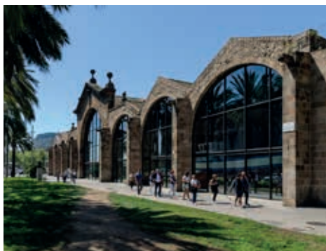
Façana de les Drassanes Reials
