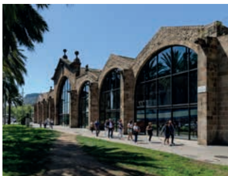
Façana de les Drassanes Reials
